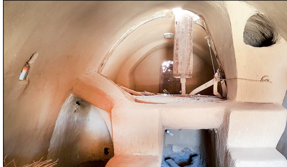
محور پره‌ها، نیروی باد را به سنگ آسیاب منتقل می‌کند
